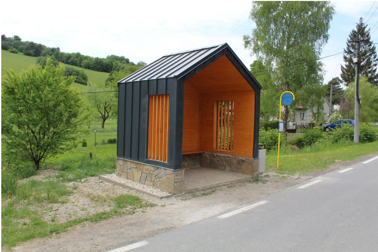
Zastávka č. 1 v obci Varadka
