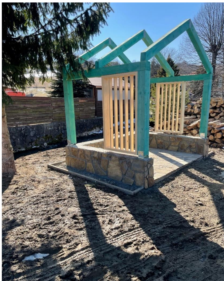
Autobusová zastávka č. 2 v obci Varadka pred a počas realizácie
