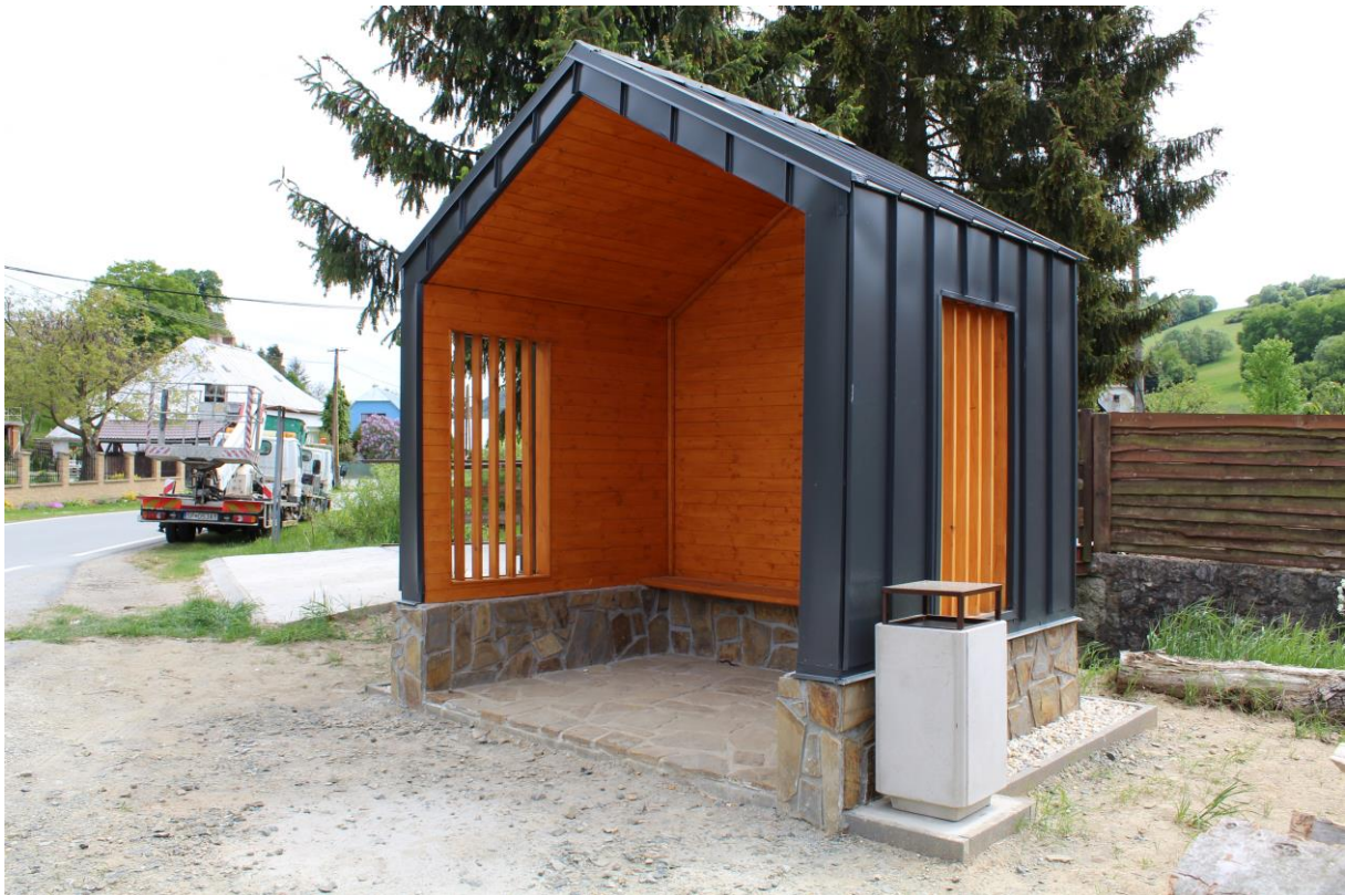
Zastávka č. 2 v obci Varadka
