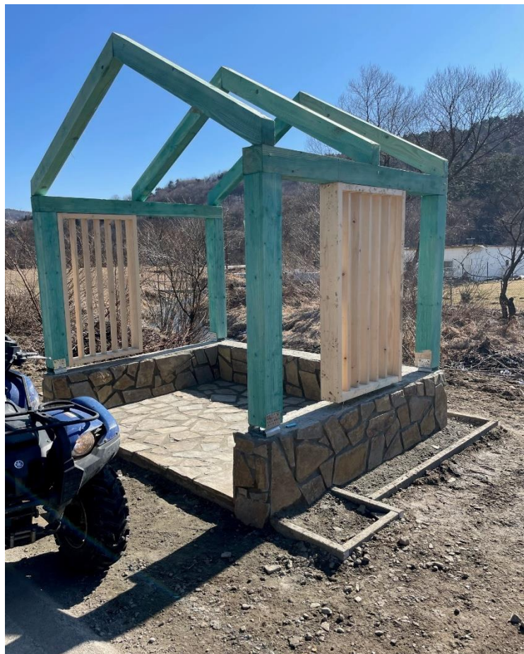
Autobusová zastávka č. 1 v obci Varadka pred a počas realizácie
