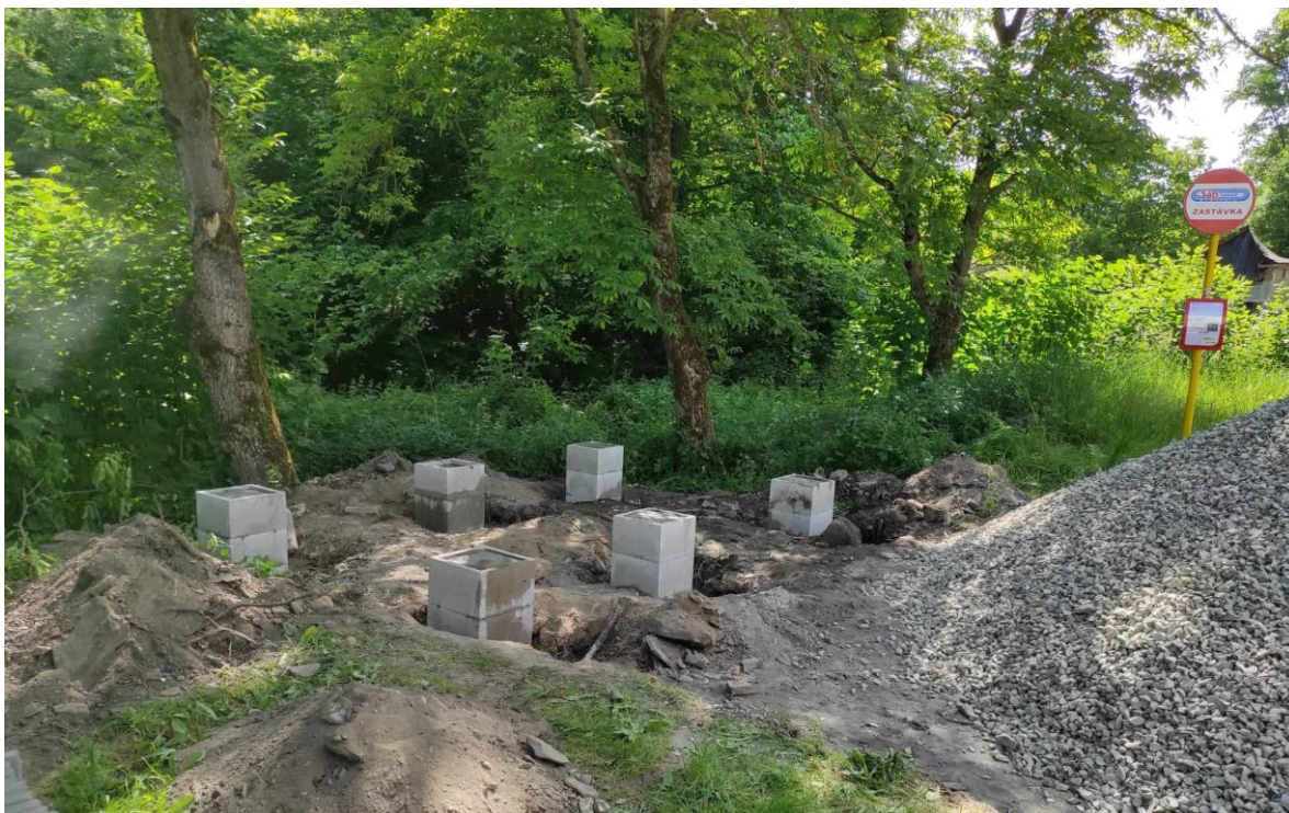
Autobusová zastávka v obci Jurkova Voľa počas realizácie
