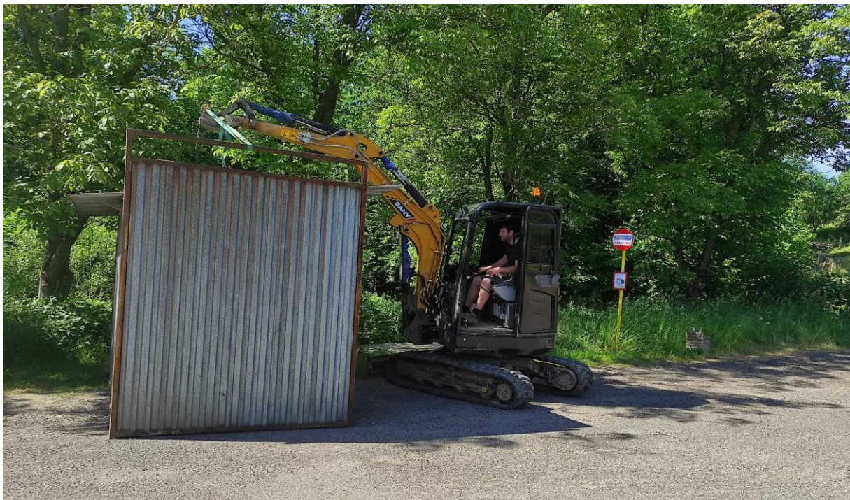
Autobusová zastávka v obci Jurkova Voľa počas realizácie
