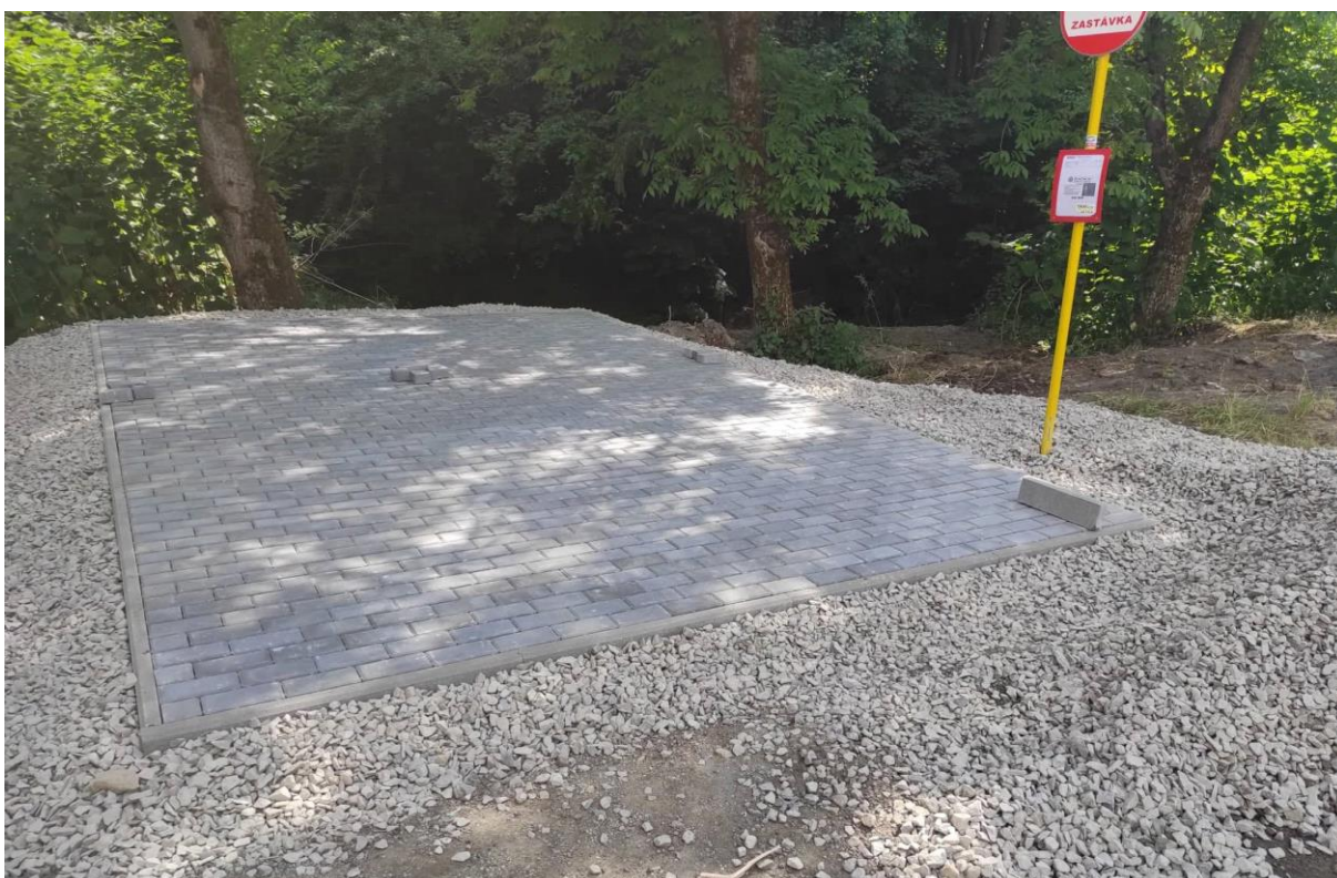
Autobusová zastávka v obci Jurkova Voľa počas realizácie
