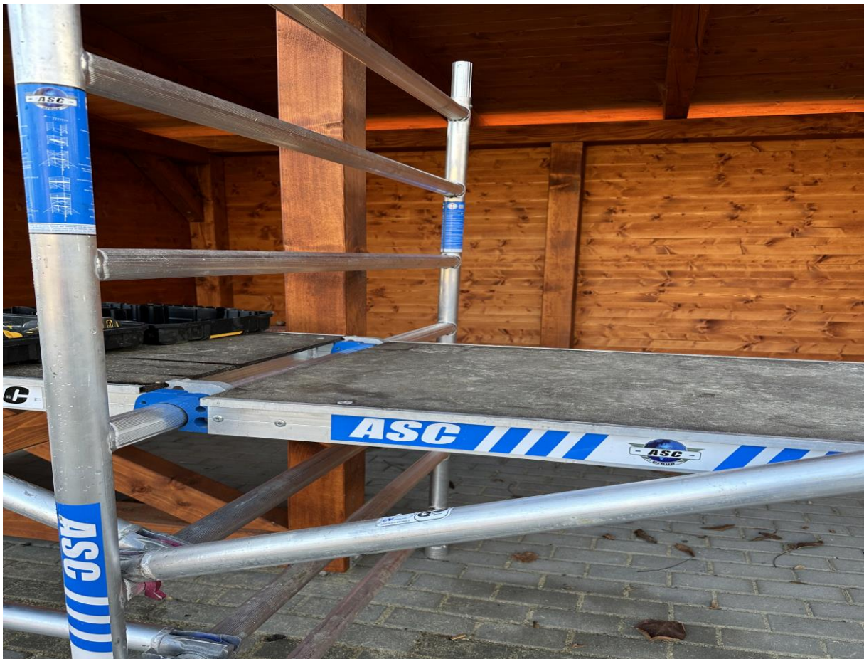
Autobusová zastávka v obci Jurkova Voľa počas realizácie
