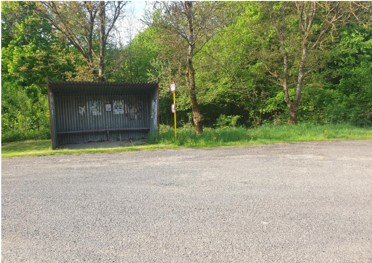
Autobusová zastávka v obci Jurkova Voľa pred realizáciou
